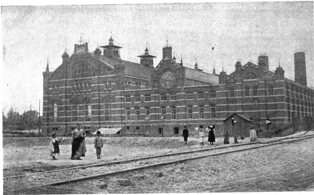
Die Wiener Städtischen Elektrizitätswerke. Die Centralstation. Original-Aufnahme. (Siehe Seite 9.)
